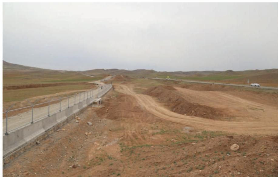
طول ۱۰۱۳۳ متر که مشتمل بر عملیات خاکبرداری، خاکبریزی، تستسیط و پخش و آب پاشی، کامپکت و اینجه فنی پل های موجود در مسیر و اجرای فنی کشی (بندنه دیوار بتی پیش ساخته مساح، ستونک ها، میله هاف شاخص ها، فنس و سیم خاردار) و ساخت ۲ عدد گیت فرعی به همراه محوطه سازی و اجرای لایه آسفالتی است.
